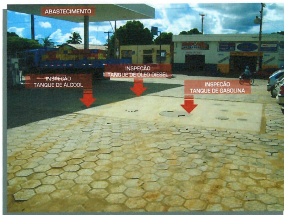
Figura 19 – Posto Alfa “Vista da Localização dos Tanques Enterrados”
